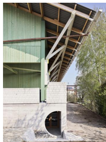
Mehrfamilienhaus «Altes Weinlager», Nuglar
