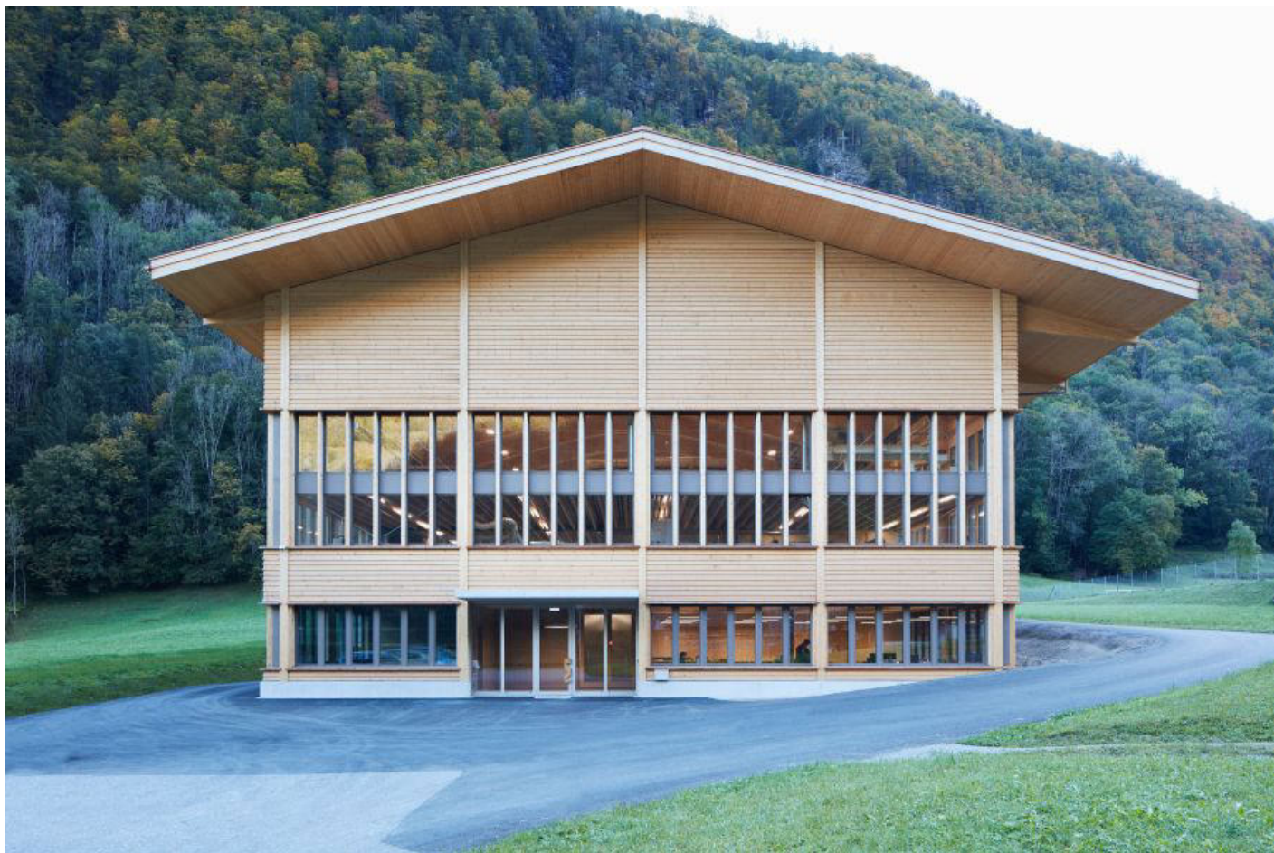
Neubau Zimmerei und Schreinerei Matt, AMJGS Architektur AG – Judith Gessler (SWB-Mitglied): Eingangsfassade mit feiner Gliederung in Vertikalen und Horizontalen. Foto: Martin Stollenwerk, Zürich.
