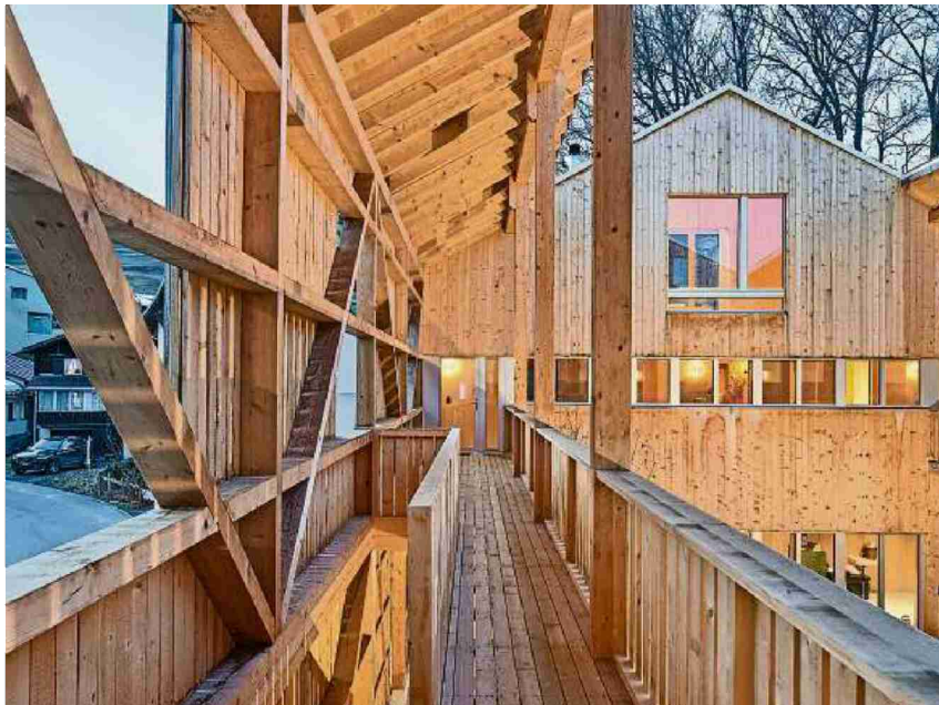
Klima- und ökologiegerecht: Das Atelier-Doppelhaus Lind in Urmein ist aufgeteilt in ein Winter- und ein Sommerhaus. Bild Ralph
